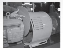
FIGURE A-4 COUPLING GUARD BARREL DRIVER END
